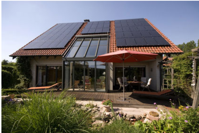
Maison avec panneaux solaires photovoltaïques – autoconsommation et revente à EDF
