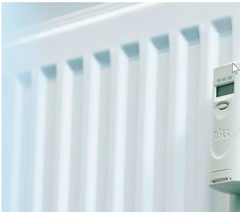
*Répartiteur de chauffage sur radiateur en rénovation de copropriété – source Ista*
