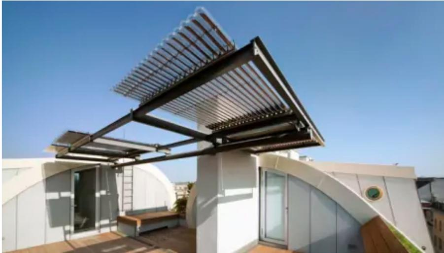
*Capteurs solaires thermiques en toiture servant à la production d'eau chaude et en soutien d'eau chaude de piscine*
