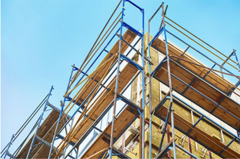
*Travaux d'isolation thermique par l'extérieur, embarqués avec la réfection de l'enduit de façade*
