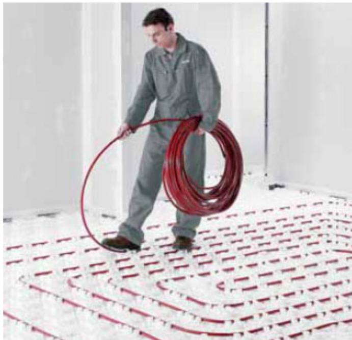
*Pose de tubes de plancher chauffant en rénovation lourde*
