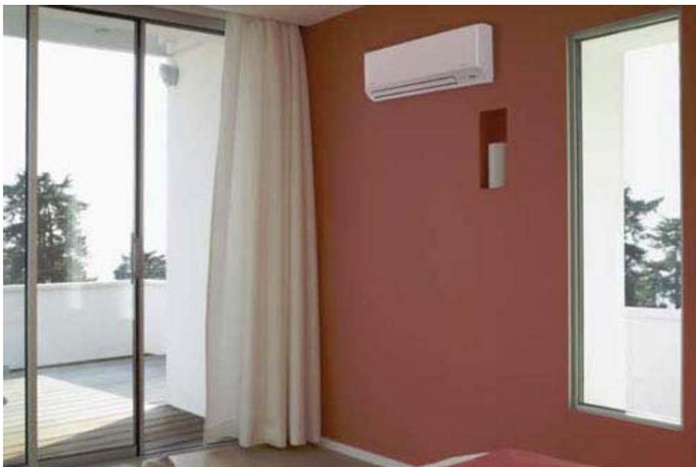
La climatisation avec des unités intérieures murales présente effectivement les niveaux sonores les plus bas comparativement au prix de l'installation. Certes, les unités intérieures sont visibles et cela peut présenter un inconvénient si l'on ne désire pas voir les unités de climatisation. Encore que certaines marques apportent une esthétique de plus en plus soignée de leurs unités intérieures de climatisation comme Daikin, Mitsubishi, LG, ...
