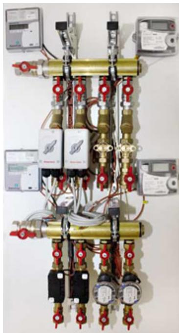
*Module hydraulique avec comptages d'énergie par appartement pour un chauffage collectif*
