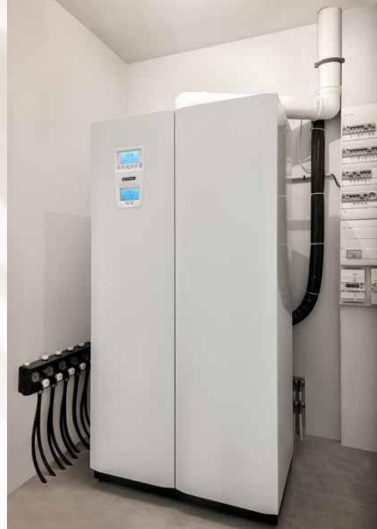
**Pour le professionnel,** la mise en œuvre est facilitée avec ses raccordements arrières multidirectionnels : Chauffage/Eau chaude/Gaz/Solaire positionnés de telle façon à faciliter l'organisation des raccordements.
